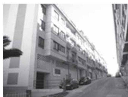
DIVERSOS PROXECTOS E ACTUACIÓNS URBANÍSTICAS EN CORRUBEDO, VALDOVIÑO, SADA E PORTONOVO.
