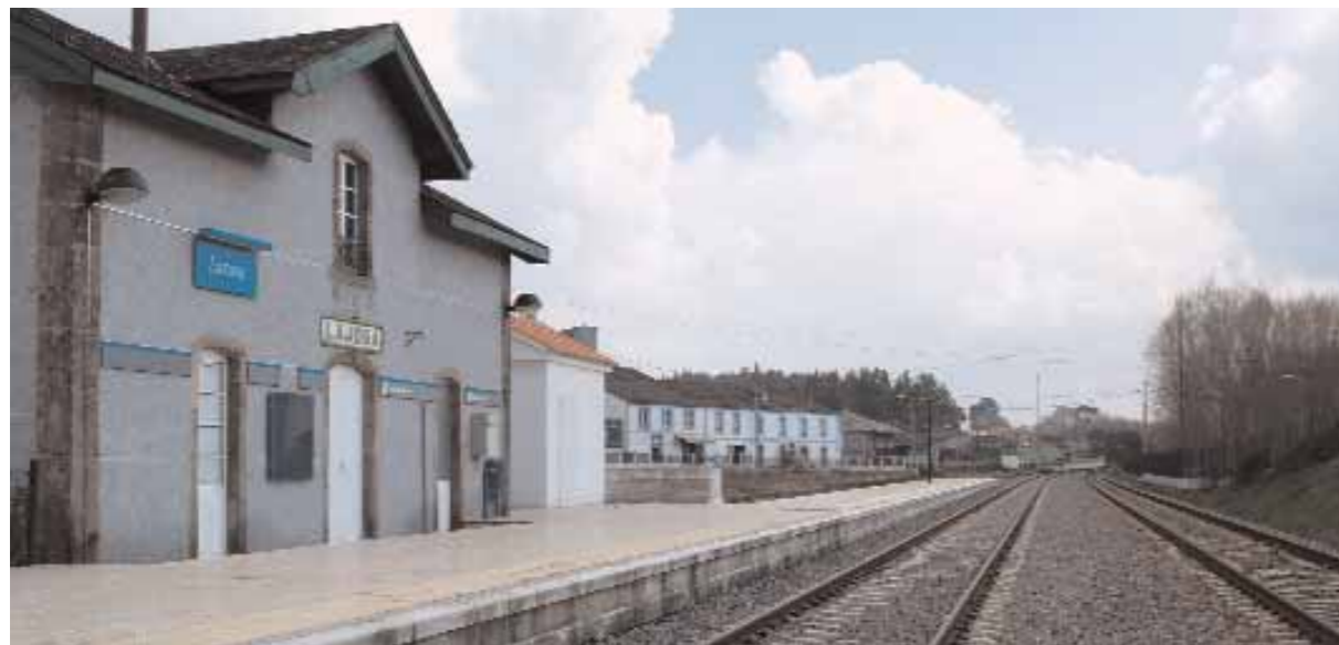
Estación de Laxosa
