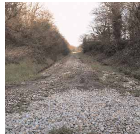
Variante de Bocelo. Desvío da vía férrea
