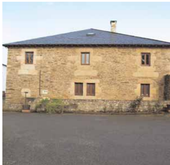
Casona en restauración, Farnadeiros
