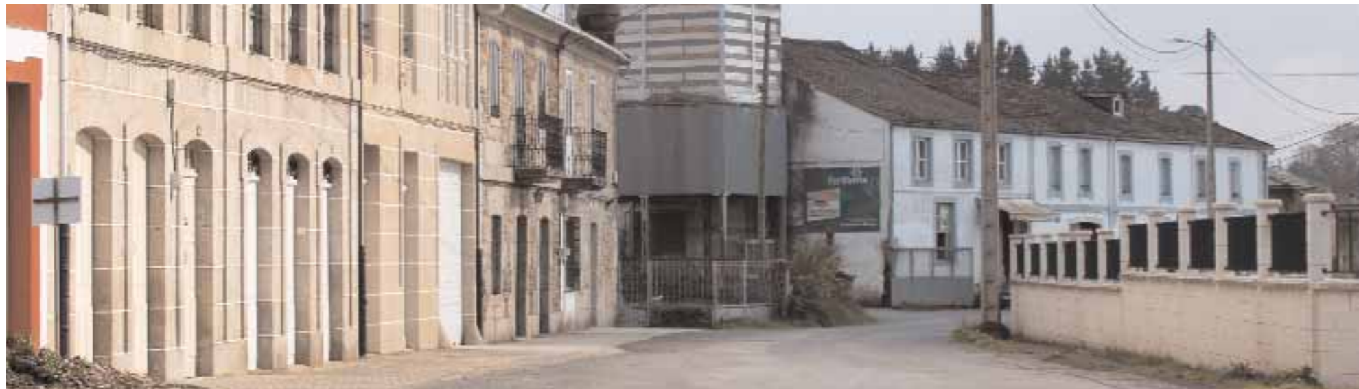
Casas Estación de Laxosa
