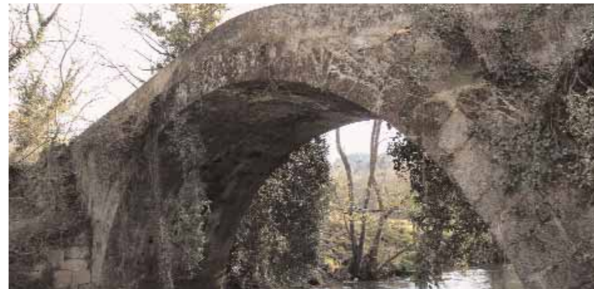
Ponte do Lago
